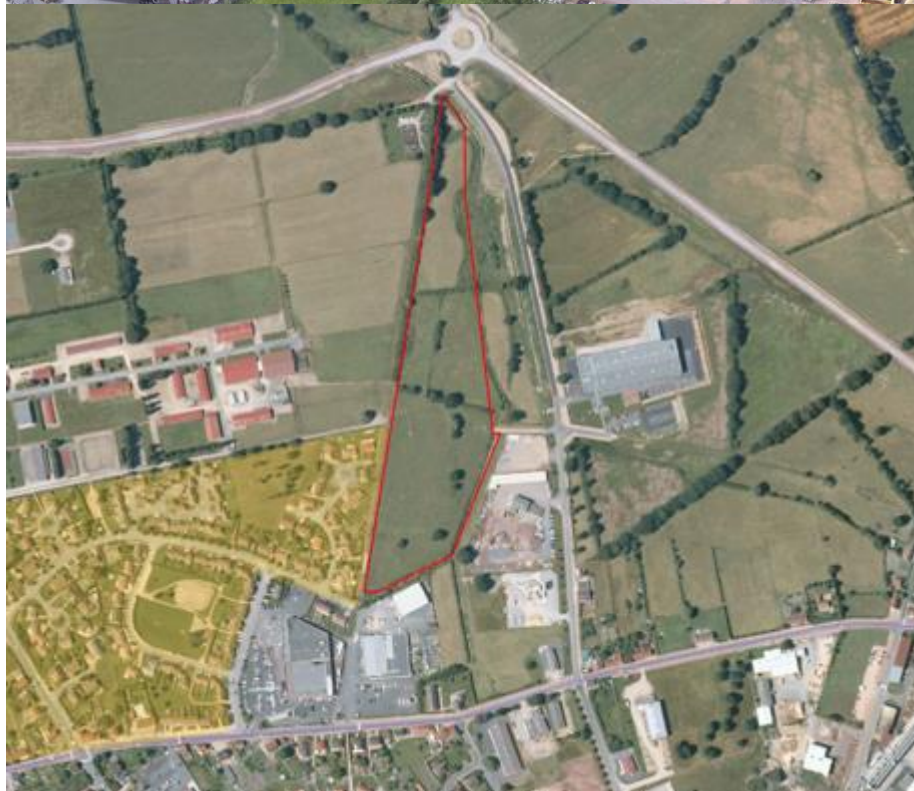
Parc solaire de Malicorne (03) – LUXEL 3,7 hectares – Construit en 2019
