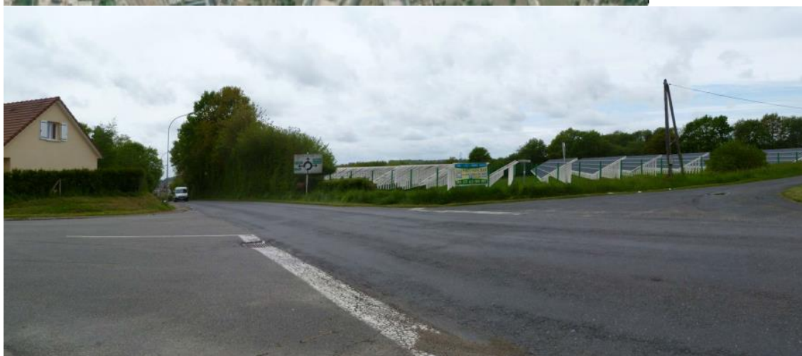
Parc solaire de La Souterraine (23) - LUXEL 7 hectares – Construit en 2021
