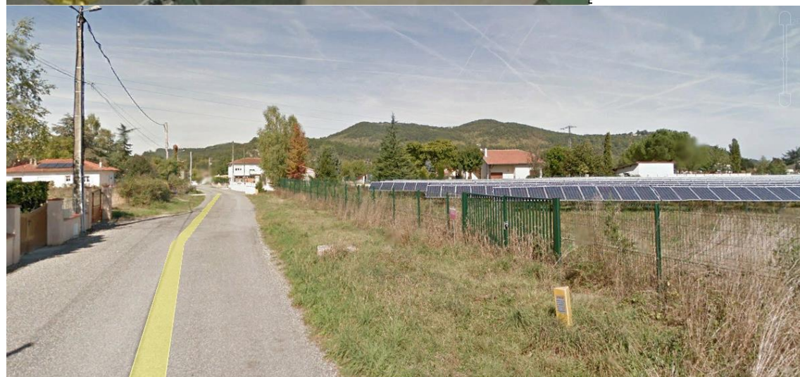
Parc solaire de Saint-Martory (31) - LUXEL 4 hectares - Construit en 2010
