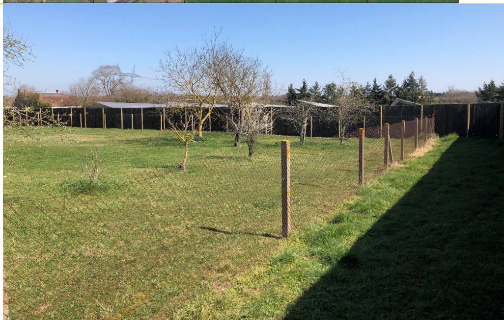
Parc solaire de Chateameillant (18) - LUXEL 5,8 hectares – Construit en 2022
