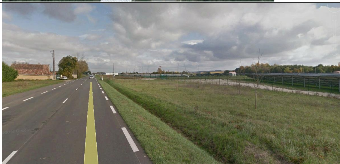
Parc solaire de Laffite-sur-Lot (47) - LUXEL 12 hectares – Construit en 2014
