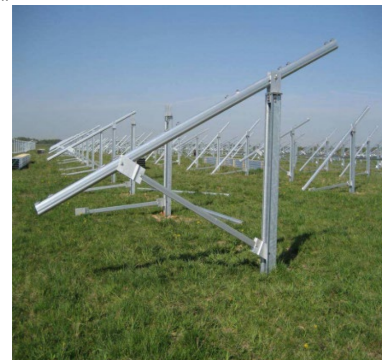
Exemple de structures et fondations envisagées
