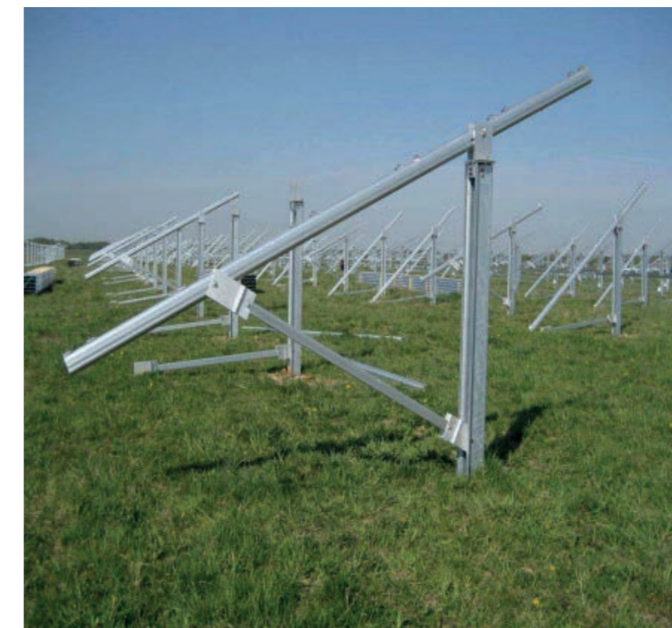
Exemple de structures et fondations envisagées
