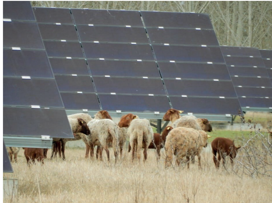
Exemple de la centrale photovoltaïque au sol de Casteljaloux (47) – complémentarité entre pâture d'ovins et photovoltaïque (source JPEE)
