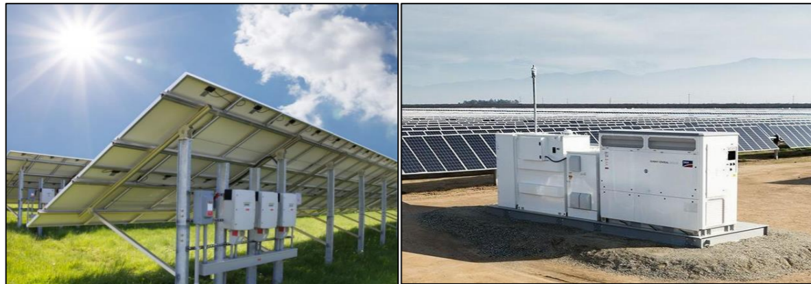
Figure 18 : Comparaison de différents onduleurs : strings ou centralisé
