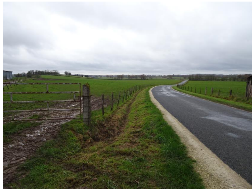
Photographie de l'état initial
