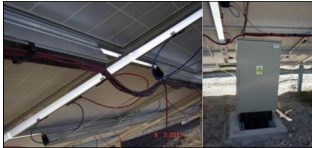
Figure 15 : Illustration du raccordement et d'une boîte de jonction (Source : VALECO)
