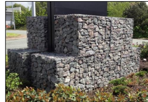
Figure 14 : Fixation par des gabions (Source : TCS Geotechnics)
