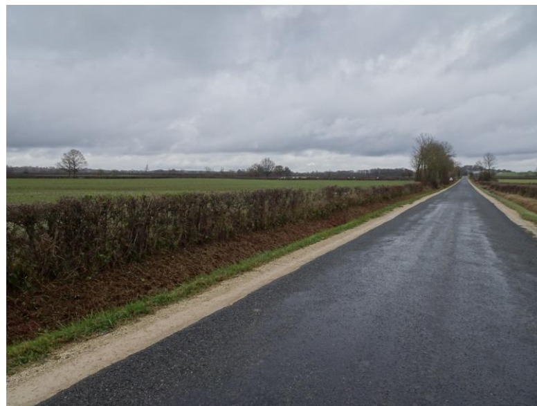
Photographie de l'état initial
