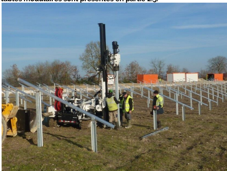
Figure 4: Mise en place de support de panneaux
