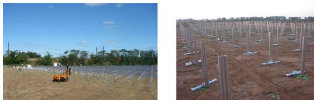
Battage des pieux
