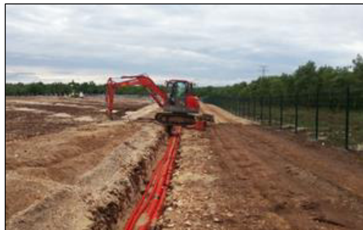
Figure 53 : Mise en place des tranchées de câbles électriques (Source : URBA 436)
