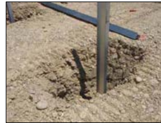
Figure 43 : Types de fondation - pieux battus
