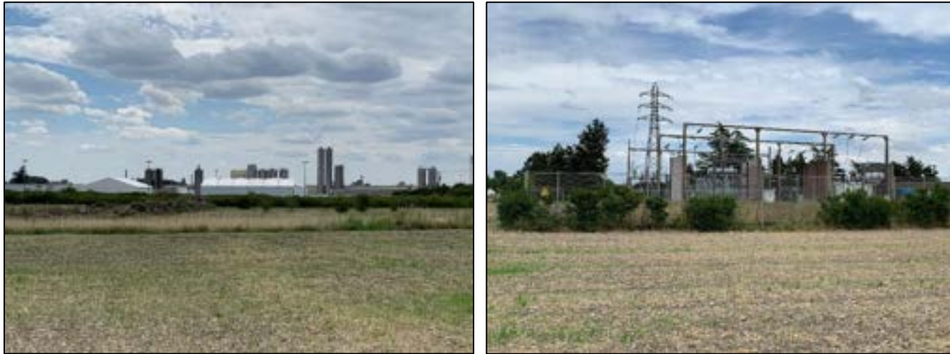
Figure 27 : Entreprise Nexans au sud-est du site (à gauche) et poste source au nord du site (à droite) (Source : NCA environnement – juillet 2022)
