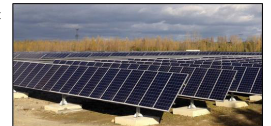
Figure 44 : Types de fondation - semelle béton
