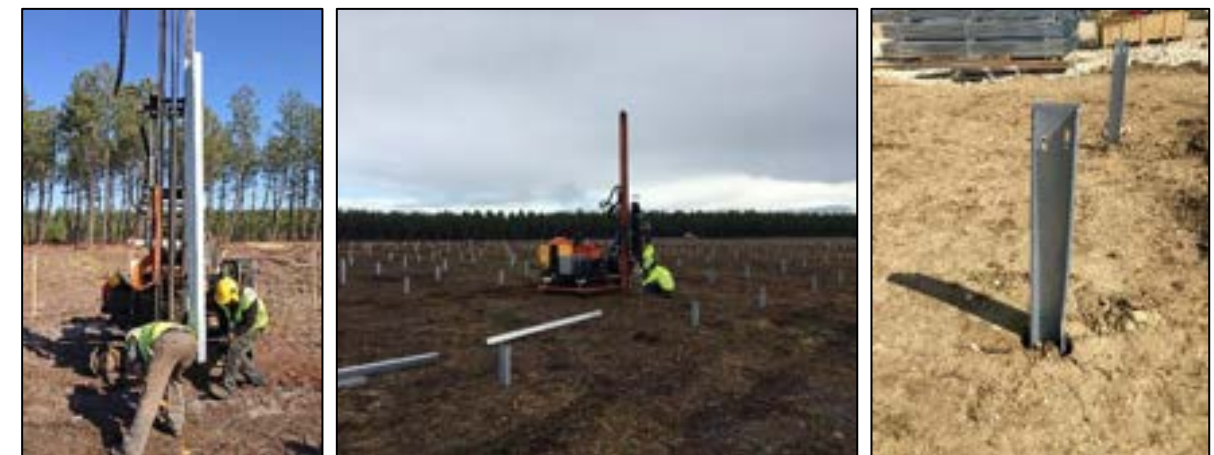
Figure 54 : Exemples de mise en place des pieux battus sur les chantiers URBASOLAR (Source : URBA 436)
