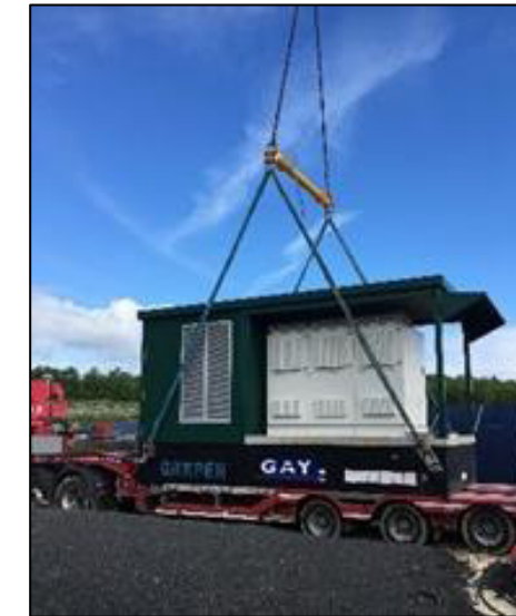
Figure 57 : Livraison d'un poste électrique (Source : URBA 436)
