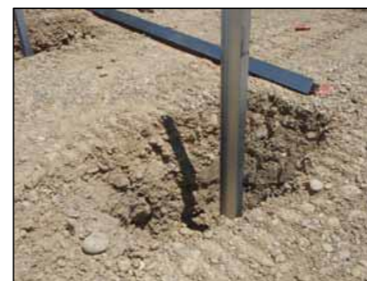
Figure 6 : Types de fondation - pieux battus (Source : Guide MEDDTL 2011 – NCA, 2015)
