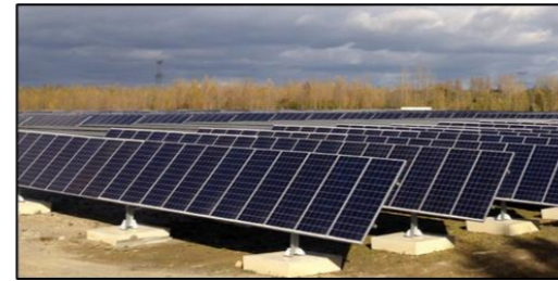
Figure 7 : Types de fondation - semelle béton (Source : URBASOLAR)
