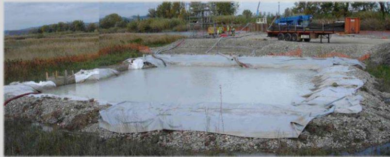
Bassin provisoire de décantation des MES et autres polluants
