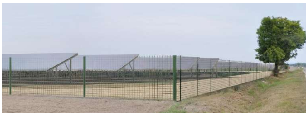
Figure 55: Exemple de clôture verte autour d'une centrale photovoltaïque
