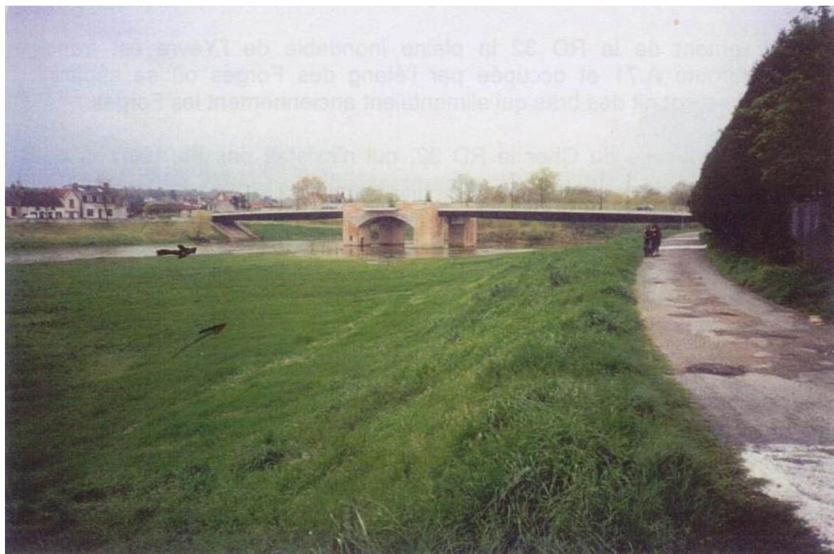
Nouveau pont sur le Cher en aval du Parc des expositions.
