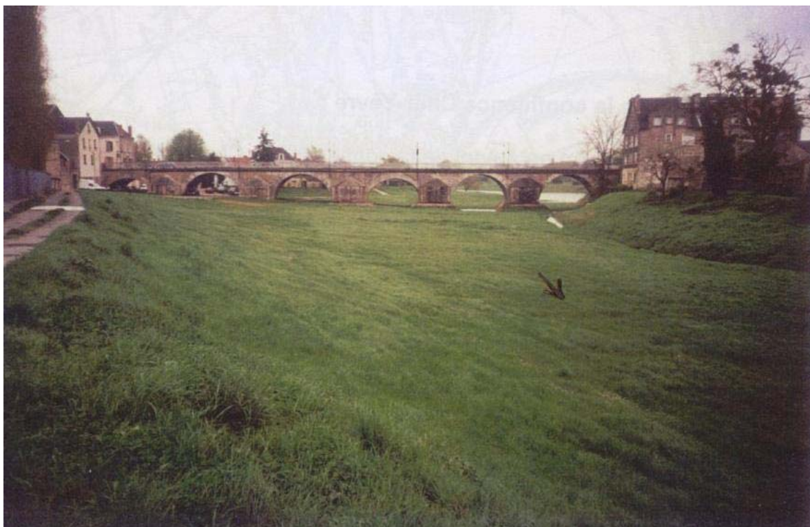
Bras de rive droite du Cher en aval du pont de l'ancienne RN 20.
