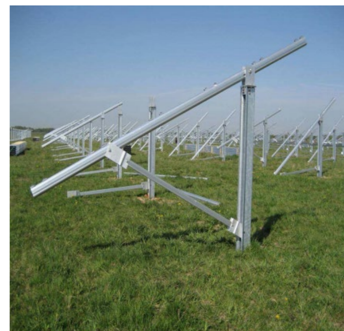
Exemple de structures et fondations envisagées
