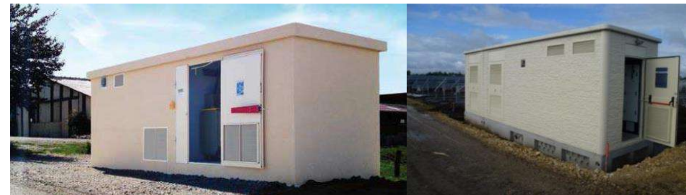
Photo 106 : Exemples de locaux techniques abritant les postes de transformation Source : JPEE
