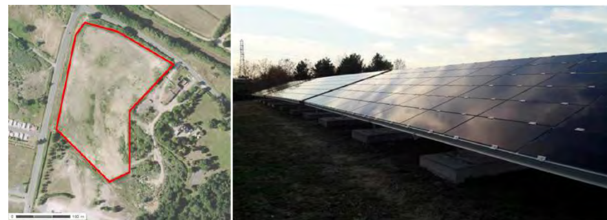
Photo 8 : Localisation et vue de la centrale photovoltaïque de Saint-Loubès (33) développée par JPee
