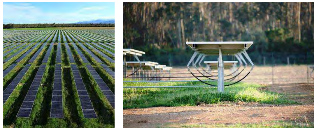
Photo 103 : Exemples de trackers mono-axe Source : EXOSUN
