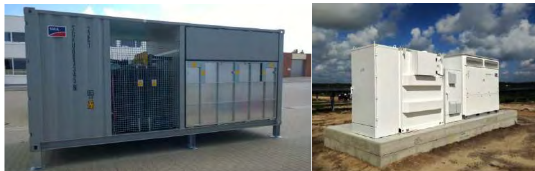
Photo 107 : Exemples de postes de transformation « container » ou « outdoor »
