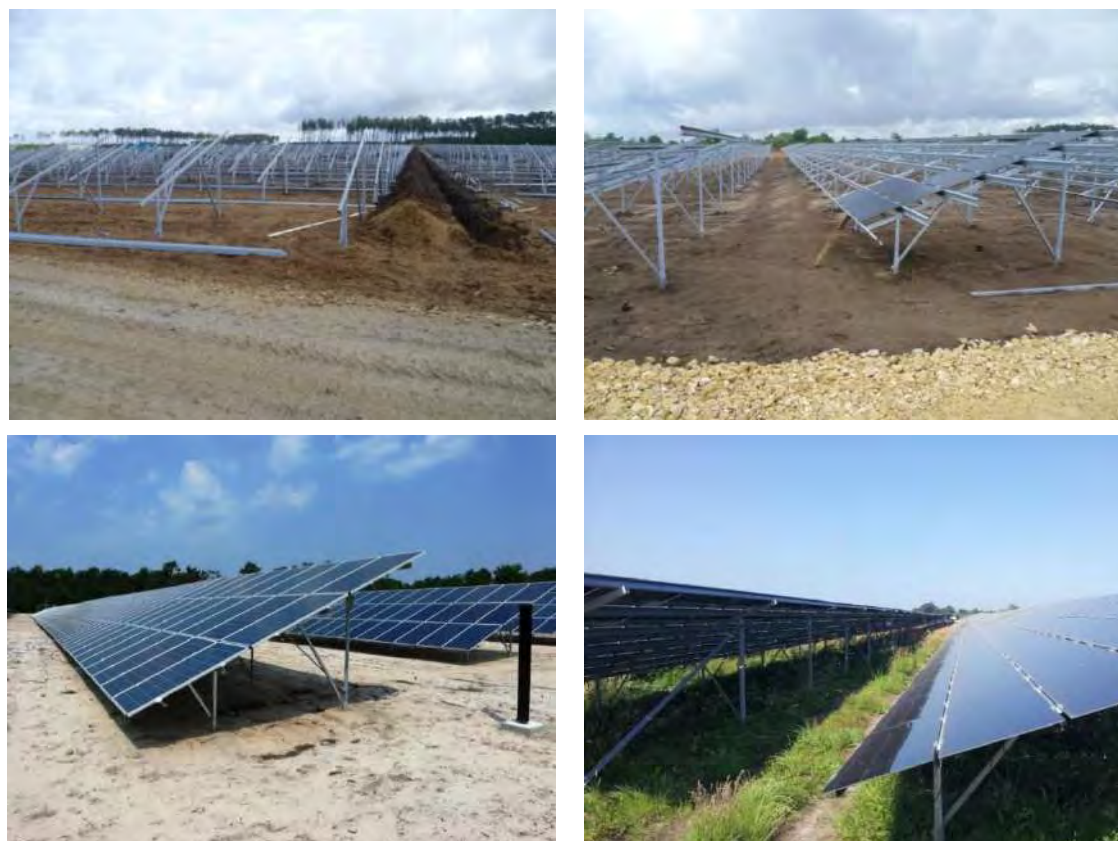
Photo 100 : Exemples de structures porteuses
