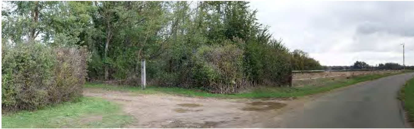
Photo 62 : Site du projet (zone sud) découvert depuis la RD 120
