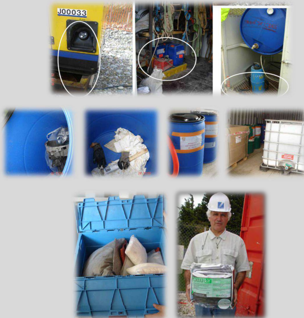
Figure 74 : Bacs de stockage des produits chimiques (Source photo : CETE)
