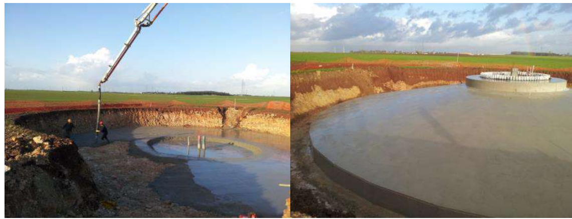
Chantier éolien – Novembre 2013
