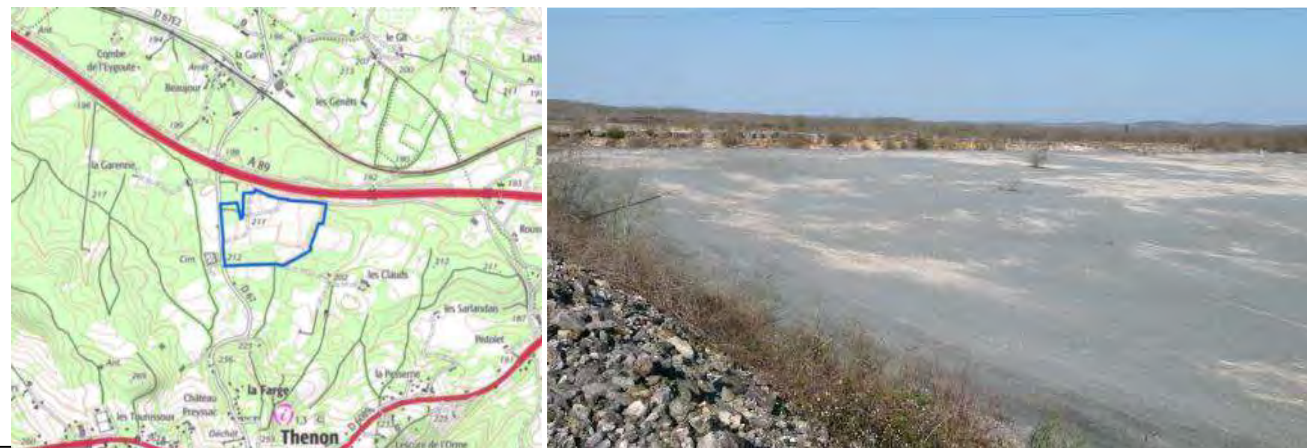
Photo 9 : Localisation et vue le site de Thenon, Source : ADEV Environnement 2016
