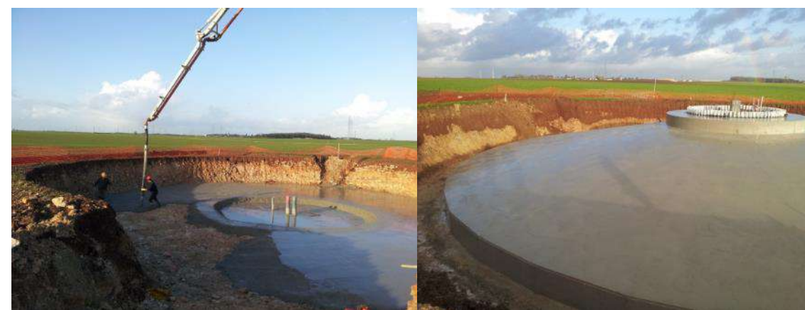
Chantier éolien – Novembre 2013
