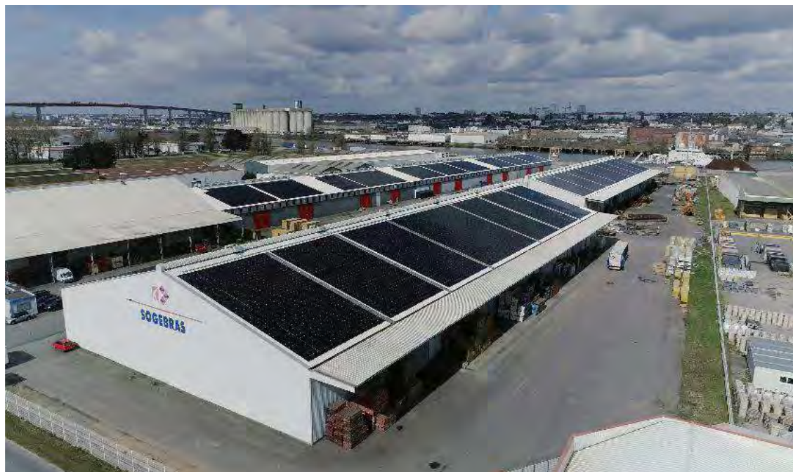
Photo 5 : photovoltaïque en toiture de Cheviré
