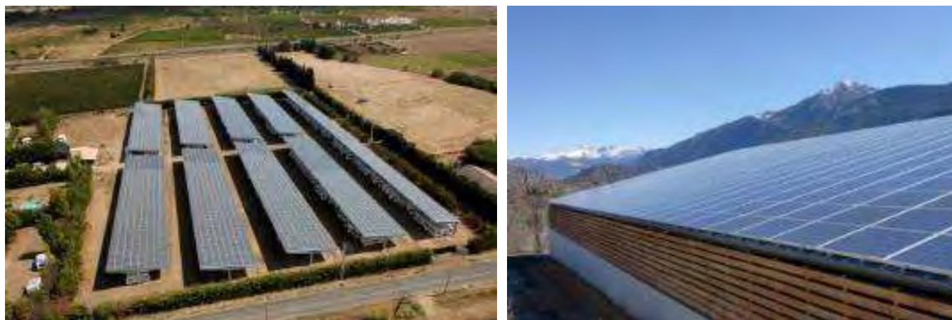
Photo 4 : Exemples d'installations photovoltaïques exploitées par JPee : les ombrières du Bosc (à g.) et la centrale d'Embrun (à d.)
