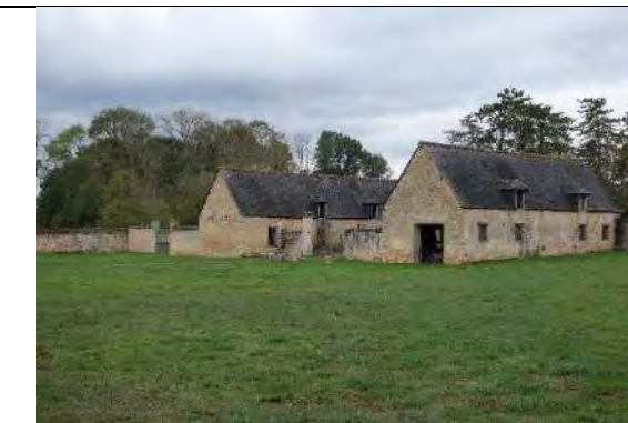
Photo 92 : Domaine de la Périssette Source : ADEV Environnement
