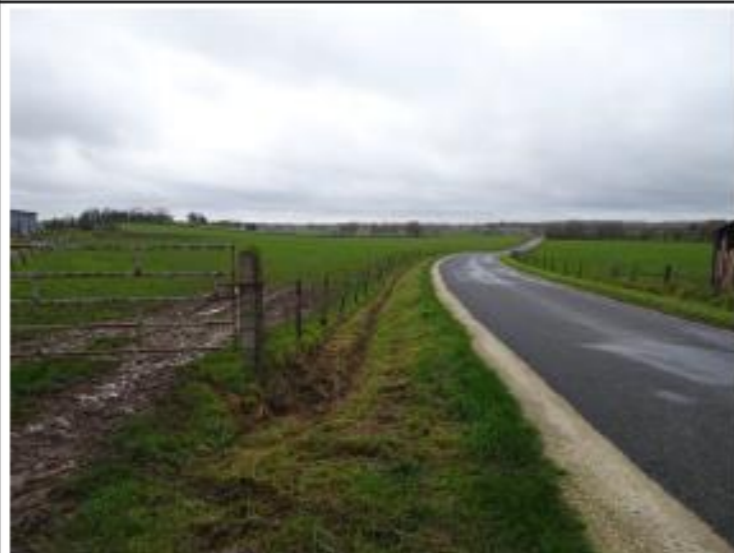
Photographie de l'état initial
