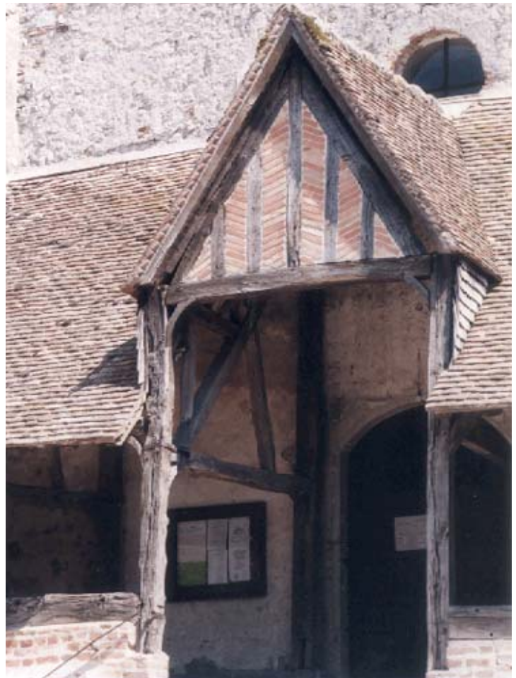
Pans de bois et tuileaux de briques, tuiles brunes pour la "caquetoire" du même édifice, dans lequel venaient "caqueter" les paroissiens de Brinon
