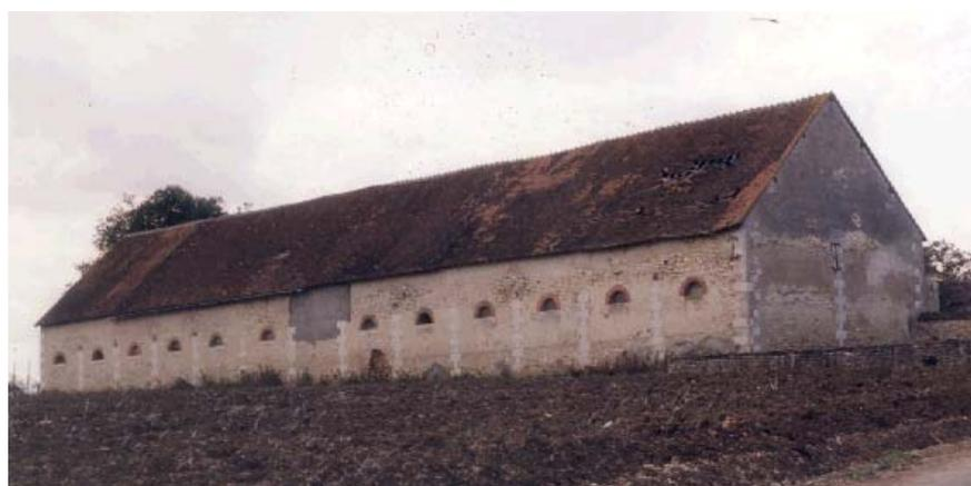
*Chaînages de calcaire oolithique taillé, maçonnerie de moellons et ouvertures ornées de briques rose, toiture de tuiles brunes pour ce bel exemple de bâtiment ancien*
