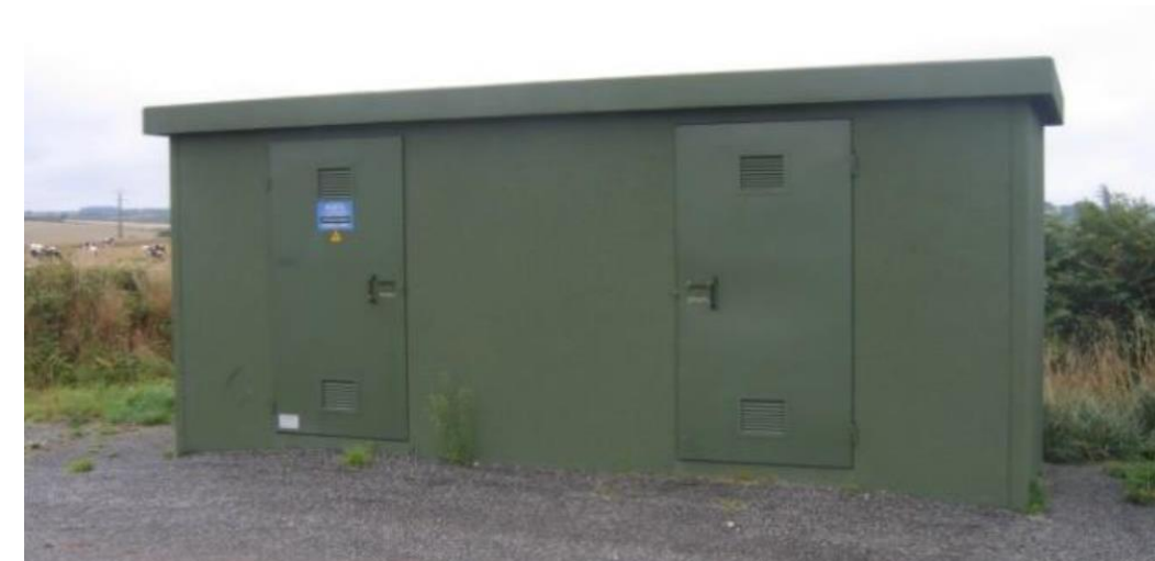
Exemple de poste de livraison électrique
