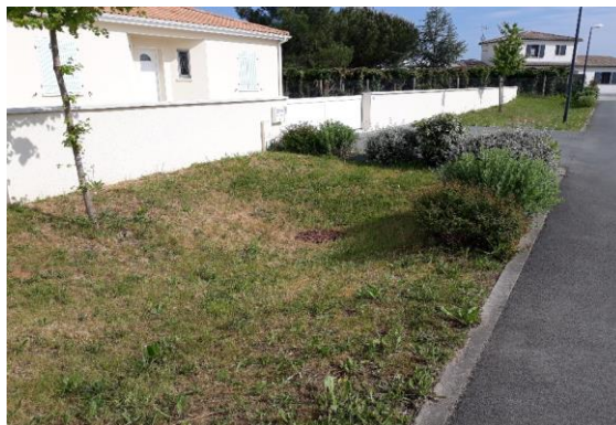
Figure 1 : Exemple de noue d'infiltration n°1
