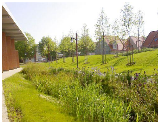
Figure 2 : Exemple de noue d'infiltration n°2
