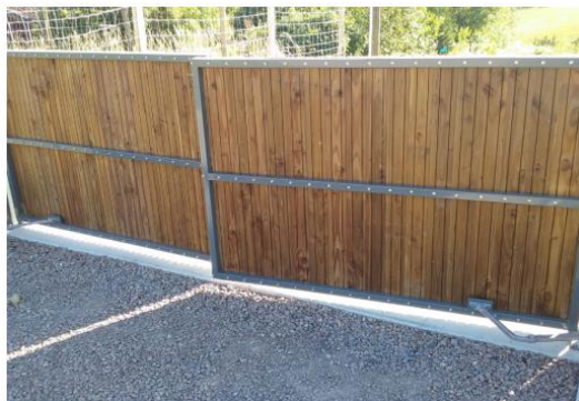
Exemple de portail en acier habillé d'un bardage bois et de clôture simple torsion en acier galvanisé – Source : www.majalo.fr
