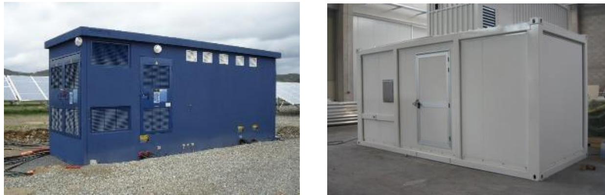
Photo 19. Exemples d'onduleurs et transformateur installés dans des postes béton et containers
