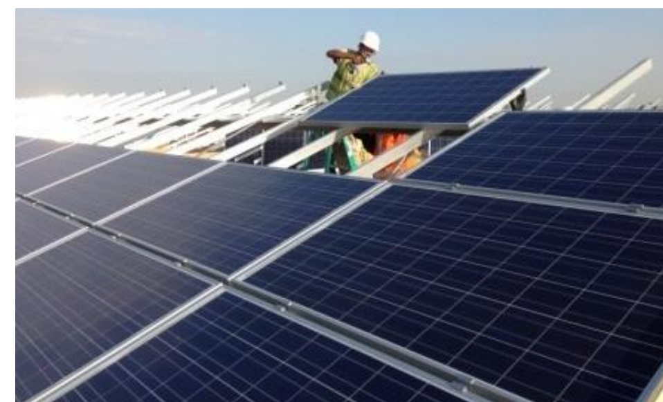
Photo 26. Exemple de mise en place des panneaux sur les structures
