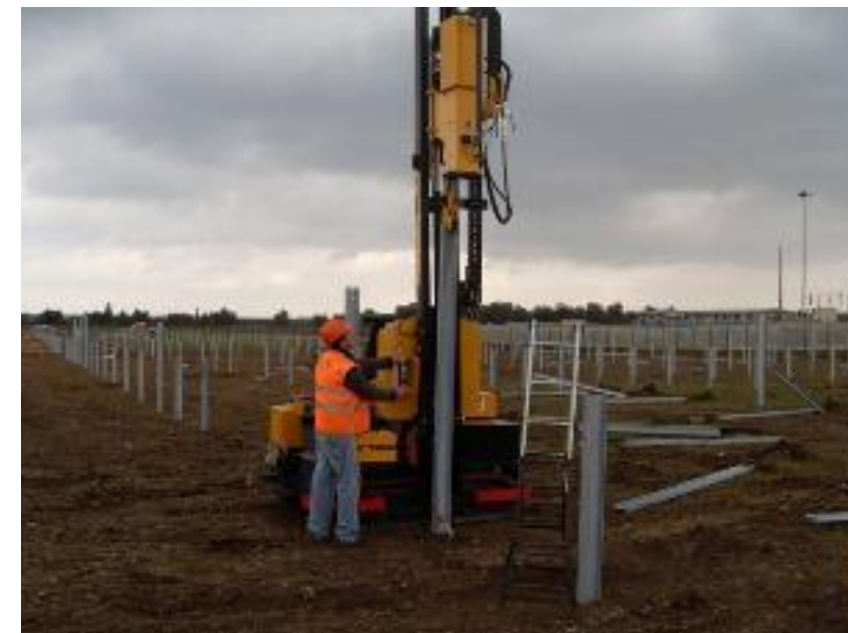
Photo 18. Exemple de fondation type pieux
