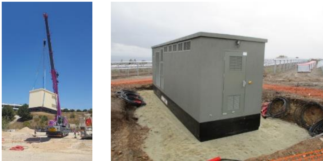
Photo 28. Installation d'un poste électrique
