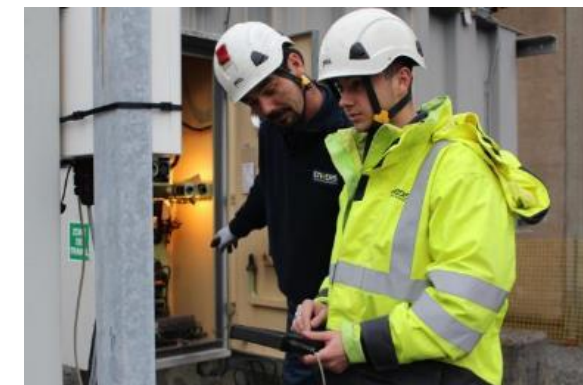
Photo 30. Mise en service par ENEDIS
