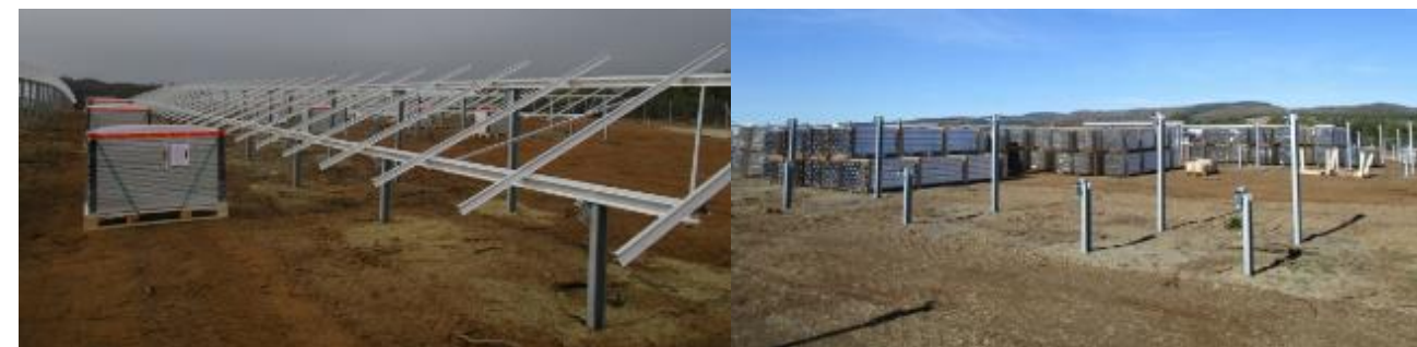
Photo 25. Assemblage des structures sur site
