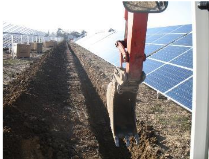
Photo 27. Exemple de tranchée entre deux tables photovoltaïques
