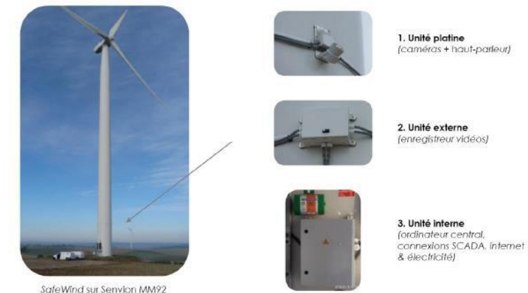
Figure 54 : Photographies présentant le dispositif de détection et anti-collision SafeWind (source : Biodiv-Wind®)
