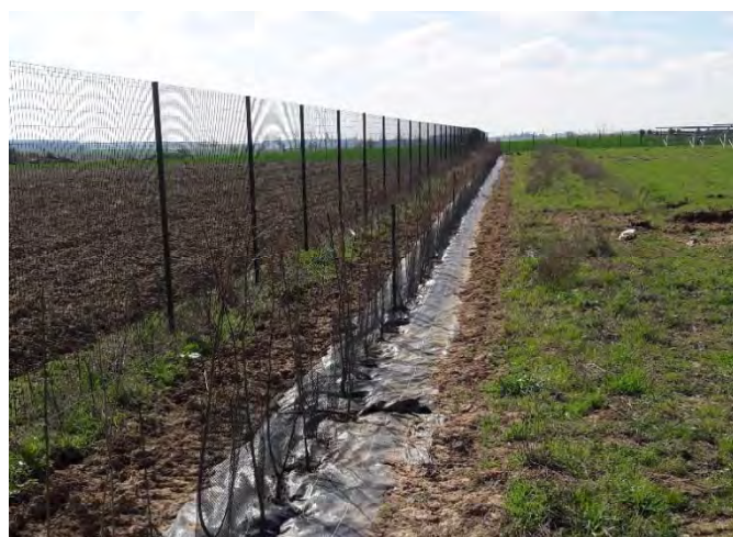
Photo 66 : Clôture et plantation de haie
