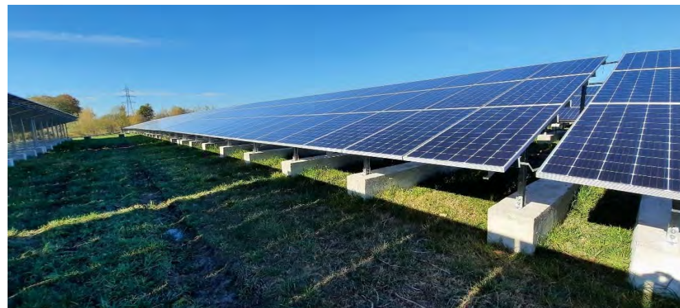
Photo 62 : Longrines béton, centrale photovoltaïque des grandes Jonchères
