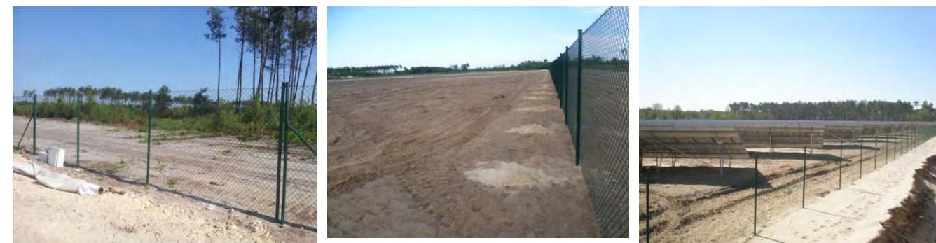
Photo 73 : Exemples de clôtures de sites photovoltaïques
