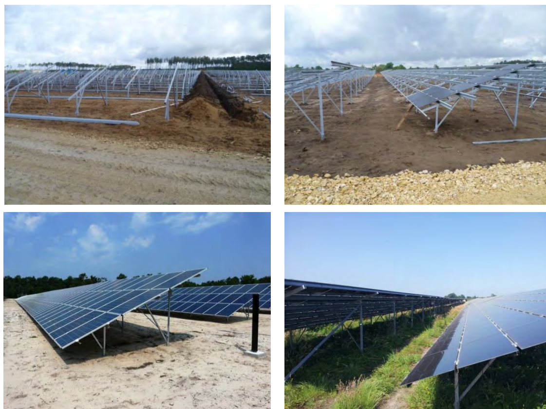
Photo 64 : Exemples de structures porteuses
