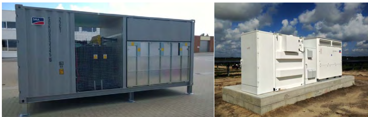
Photo 71 : Exemples de postes de transformation « container » ou « outdoor »
