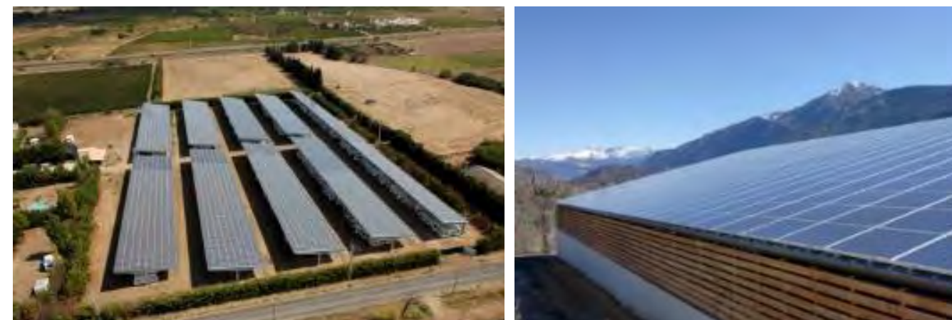
Photo 10 : Exemples d'installations photovoltaïques exploitées par JPee : les ombrières du Bosc (à g.) et la centrale d'Embrun (à d.)
