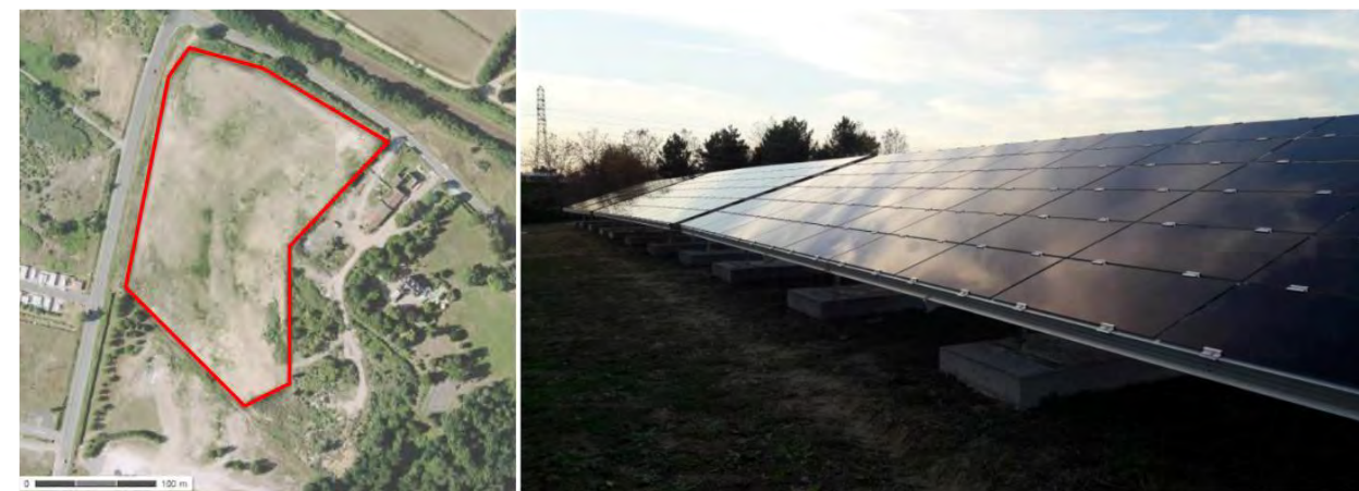
Photo 14 : Localisation et vue de la centrale photovoltaïque de Saint-Loubès (33) développée par JPee
