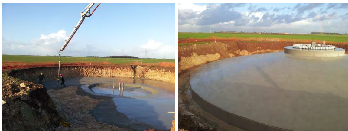
Chantier éolien – Novembre 2013
