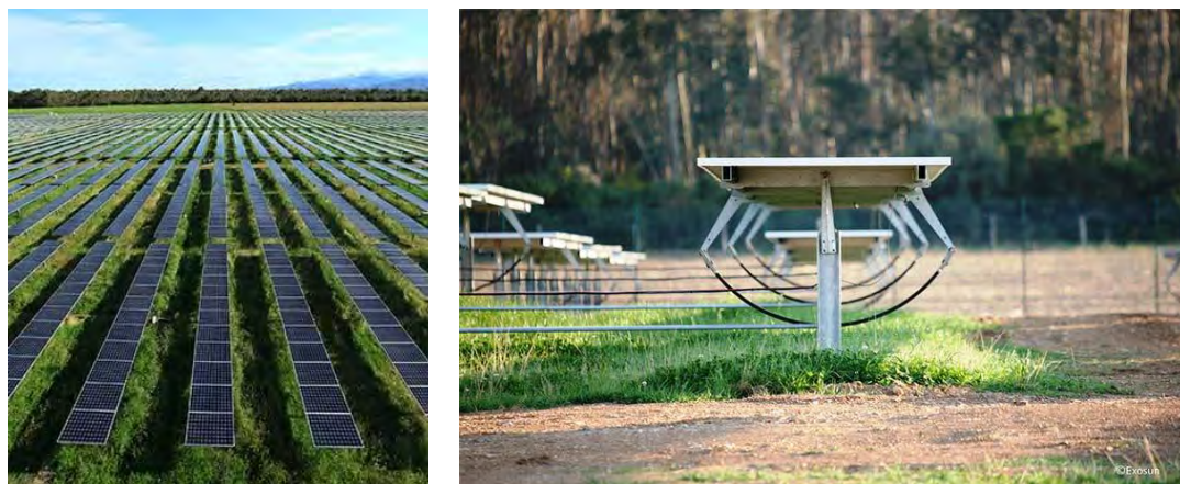
Photo 67 : Exemples de trackers mono-axe Source : EXOSUN
