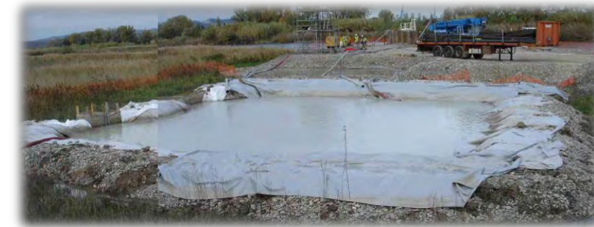
Figure 10 : Bassin provisoire de décantation des MES et autres polluants
