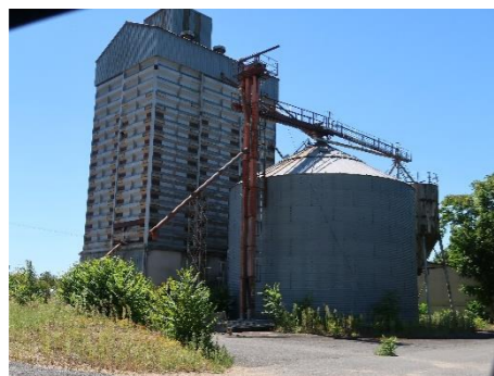
Silo à Chambon Source : ARTIFEX 2022
